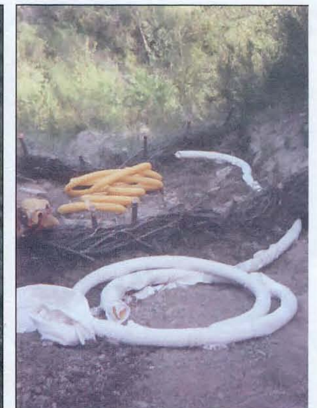
Foto 11 – Dreni suborizzontali e fascinate.
