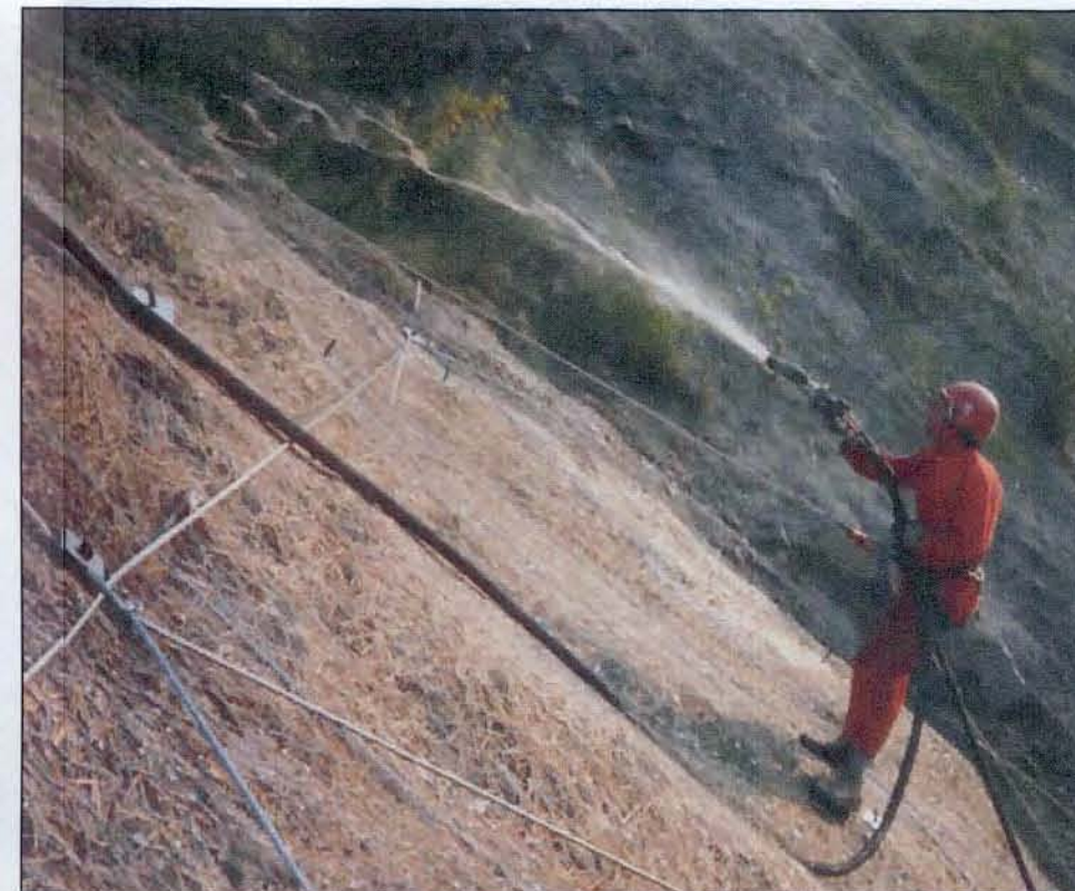
Foto 10– Lavorazione in parete: idrosemina.
