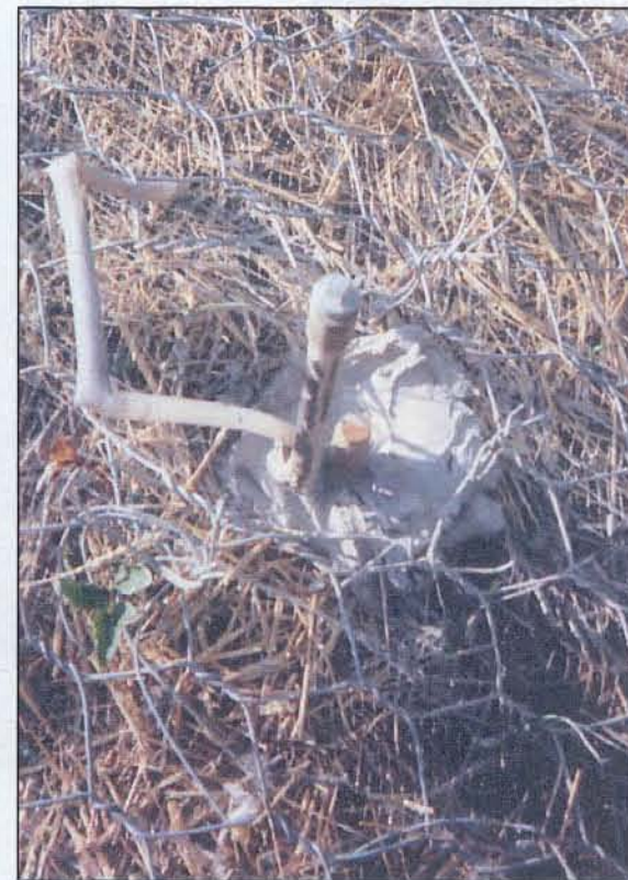
Foto 9– Particolare ancoraggio profondo micropali.
