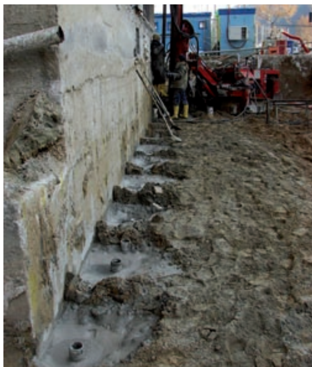
Micropali in fase di realizzazione in aderenza all'edificio esistente
