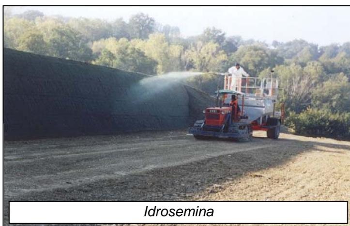
Per un miglior inserimento ambientale dell'opera, il paramento esterno della scarpata è stato trattato mediante idrosemina di un'adatta miscela di sementi; in poco tempo una folta copertura vegetale ha così fatto la sua apparizione rendendo più gradevole e a minor impatto visivo il fronte della scarpata di origine antropica.
