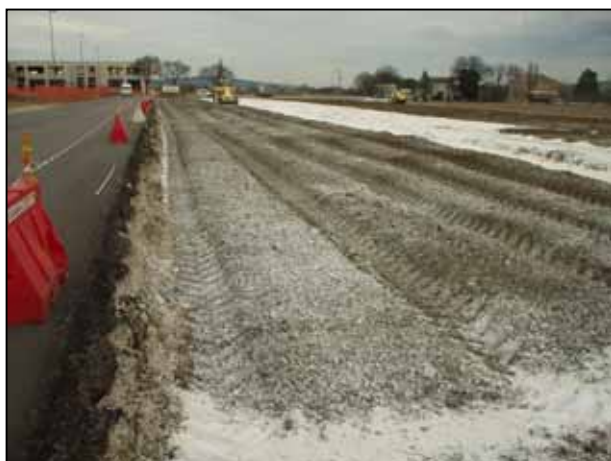
Miscelazione del terreno con la calce.
