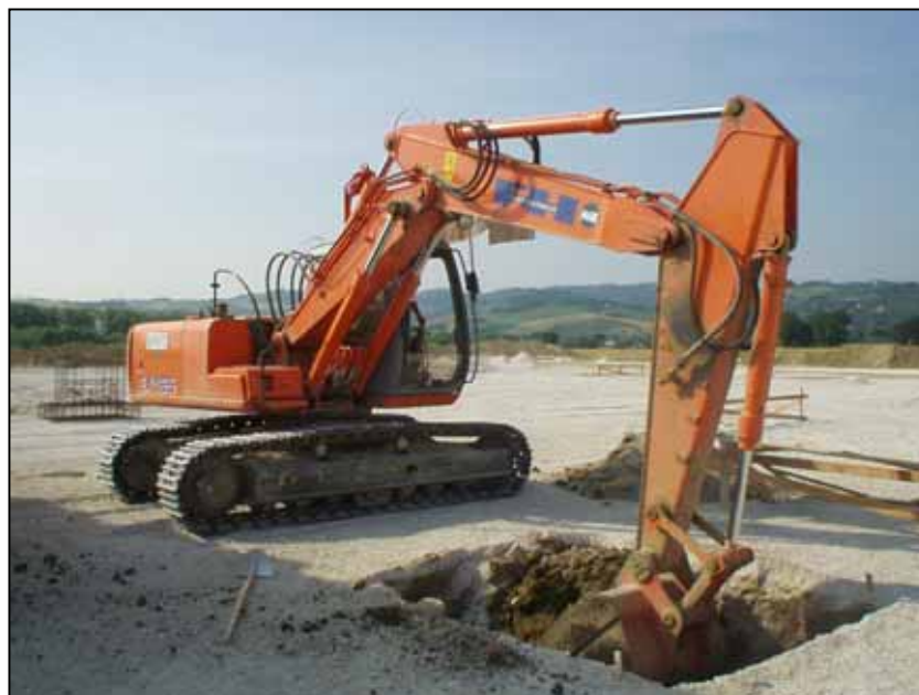
Esecuzione degli scavi a sezione obbligata per la realizzazione delle fondazioni.
