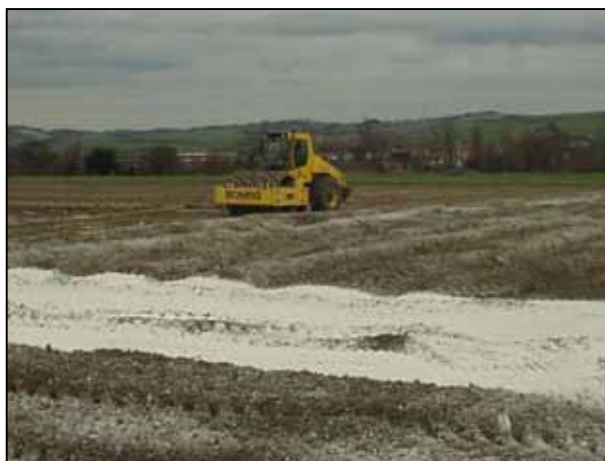
Costipamento del terreno con rullo a piede di montone
